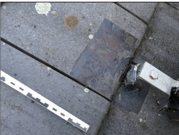
Abbildung 47 Mit Dichtbahnstücken bearbeitete Durchdringungsstellen der Dachhaken
