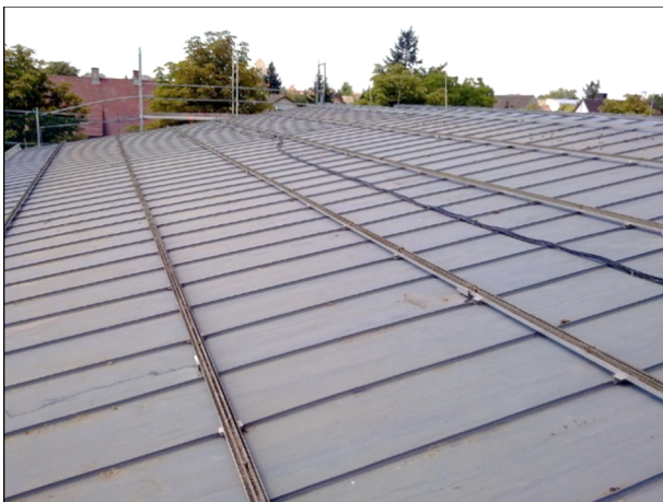
Abbildung 97 Zinkblechdach nach Demontage der PV-Module
