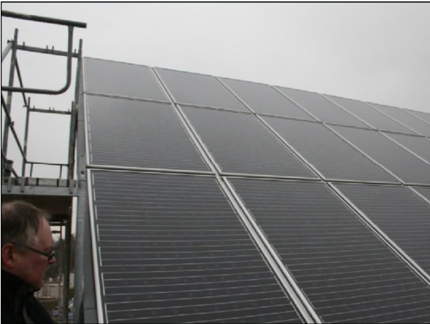
Abbildung 147 Indachanlage ohne weitere Deckmaterialien
