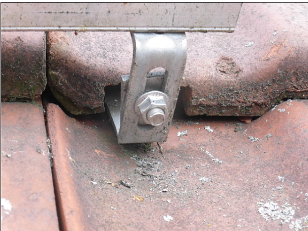
Abbildung 23 Ausgefräste Fußrippe für die Durchdringung des Dachhakens
