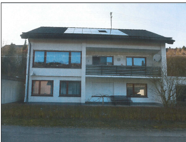
Abbildung 41 PV-Anlage über nicht ausgebautem Dachgeschoss
