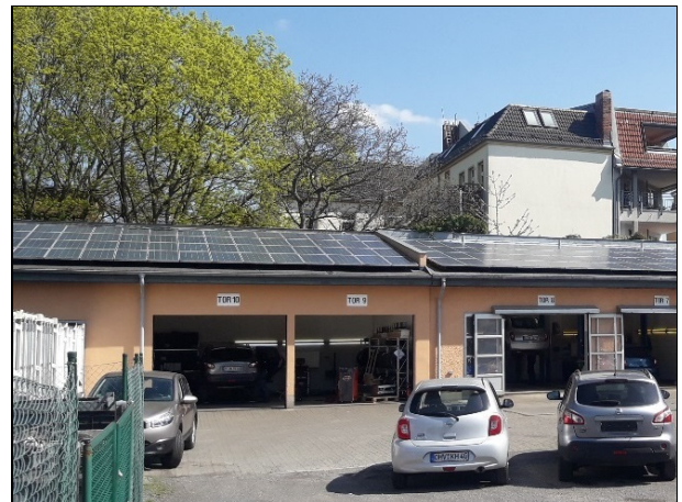
Abbildung 163 PV-Module wurden bis an die Brandwand herange- führt
