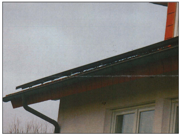
Abbildung 153 Detailaufnahme des Dachrands
