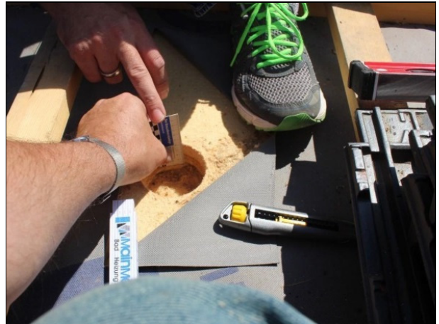
Abbildung 52 Graue Unterdeckbahn (weggeklappt), darunter 4 cm Holzfaserdämmung oberhalb der Dachsparren
