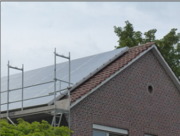
Abbildung 21 Dachfläche mit PV-Anlage
