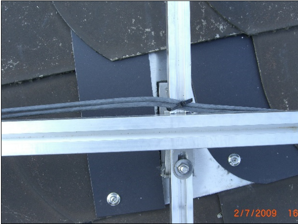
Abbildung 69 Befestigung neuer Dachplatten durch die Blechformelemente hindurch
