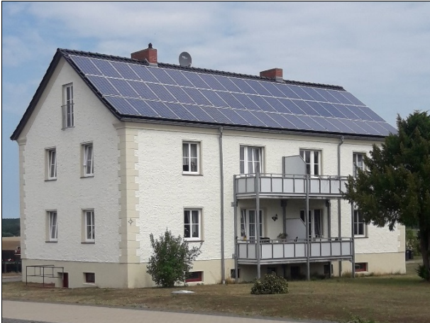
Abbildung 167 Mindestabstände zum Schornstein bei einem Mehrfamilienhaus in Mecklenburg-Vorpommern unterschritten
