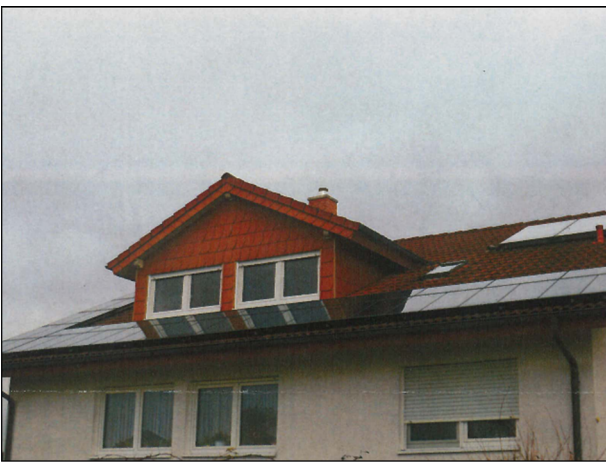
Abbildung 152 Einbau von PV-Elementen im Traufbereich
