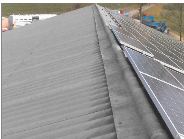
Abbildung 125 Dachfläche mit Wellfaserzementplatten, einseitig mit einer PV-Anlage versehen. Die PV-Anlage überdeckt die Befestigung der Firstelemente.
