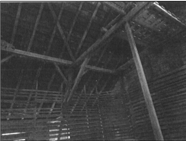
Abbildung 25 Scheunendach mit Ziegeleindeckung ohne Zusatzmaßnahme
