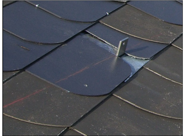
Abbildung 70 Neu montierter Dachhaken in Faserzementplatten- deckung.
