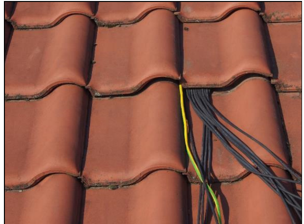
Abbildung 188 ungeschützte Einführung von Strangleitungen
