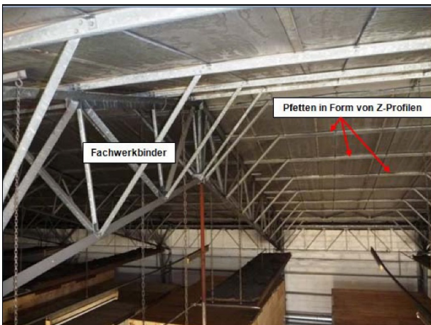
Abbildung 115 Stahlfachwerk mit Pfetten aus Z-Profilen
