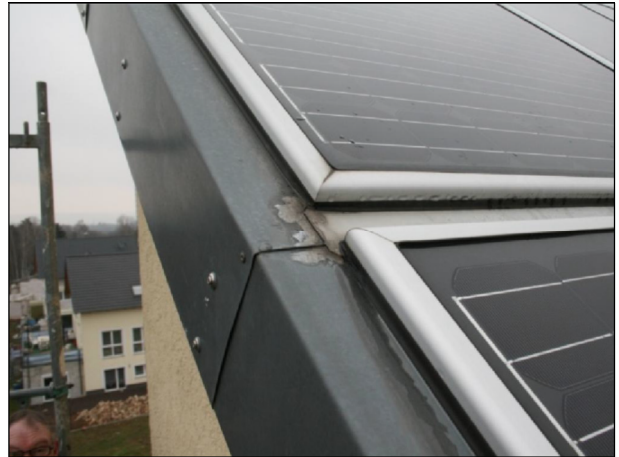
Abbildung 148 Die Dachränder wurden mit Titanzinkblechen ausgebildet.
