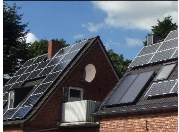
Abbildung 168 Mindestabstände zum Schornstein bei zwei Einfamilienhäuser in Schleswig-Holstein unterschritten
